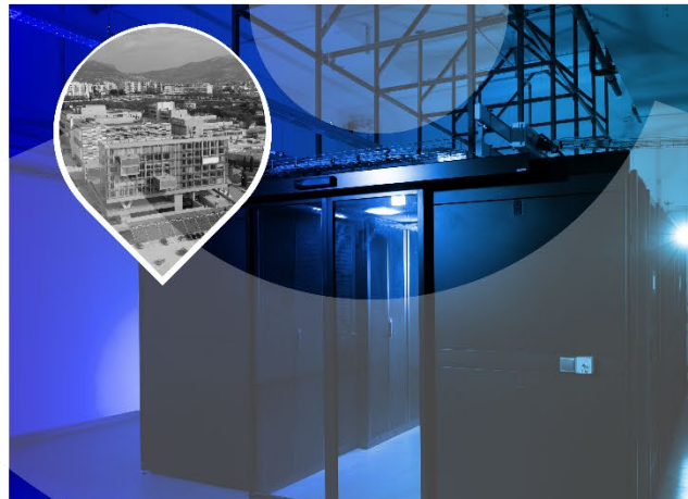
Podatkovni centar u Splitu HR-ZOO ST 📍 Sveučilište u Splitu, Sveučilišni kampus Visoka
